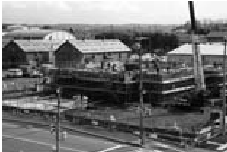
建設が進む風連本町地区の総合支援施設 (風連国保診療所 ・ 風連健康施設)
