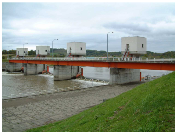
真勲別頭首工
