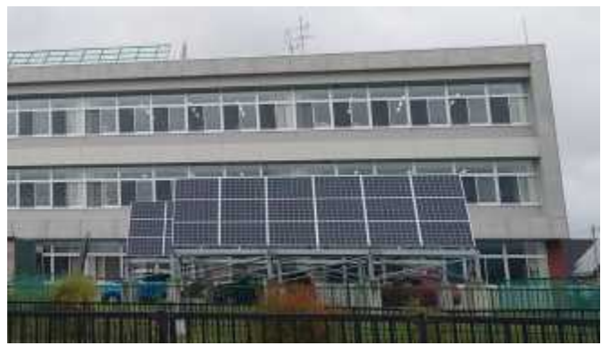
写真 名寄南小学校 敷地への太陽光発電設置事例
