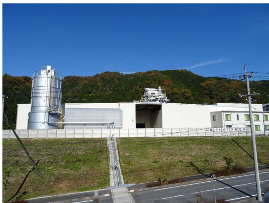
図 3.14 岡山県真庭市での木質発電事例
