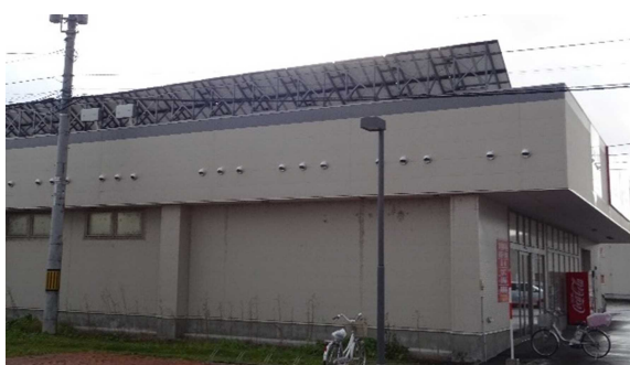
写真 4.2 建物屋根への太陽光発電設備の設置事例
