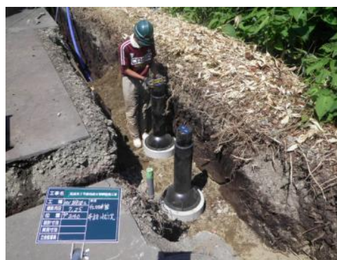
(仕切弁管布設工)
