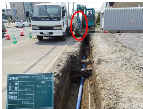
(配水管布設工)
