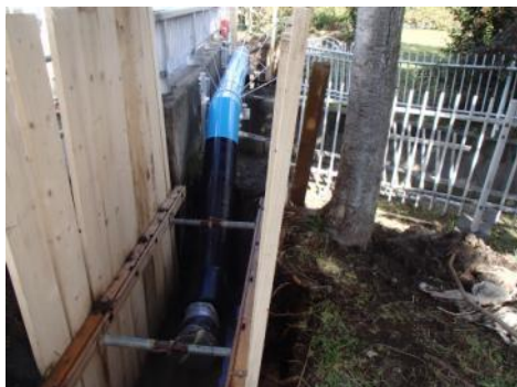
(送水管橋梁添架工)
