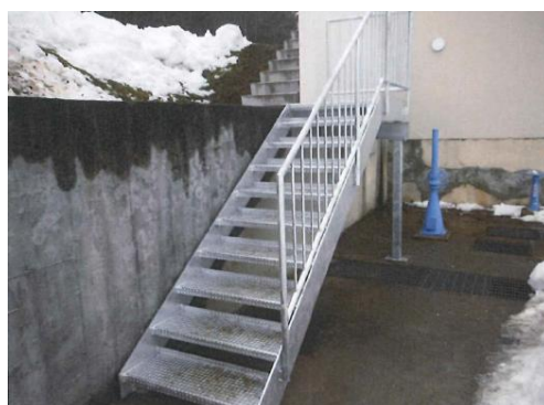
(導水ポンプ場階段改修)
