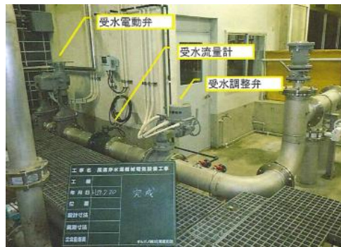
(風連浄水場内設備改修)
