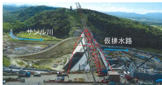
(サンルダム工事)
