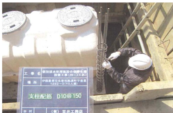
(10人槽浄化槽設置工)
