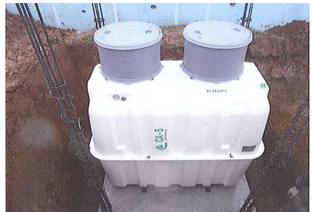
(施工写真②・浄化槽設置)
