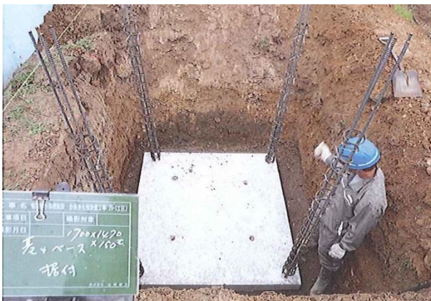
(施工写真①・底版据付)
