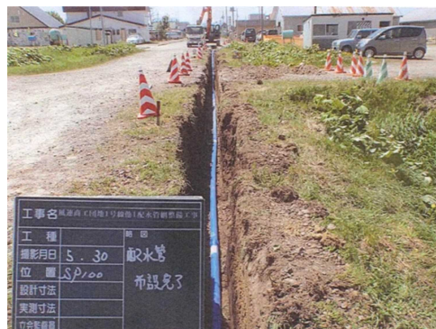
(配水管敷設工)
