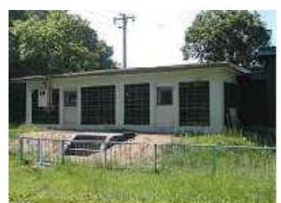
風連日進地区浄水場
