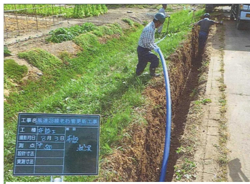
(老朽管敷設工)
