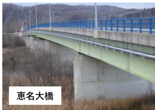
(配水管橋梁添架)
