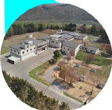
空から見た緑丘浄水場
