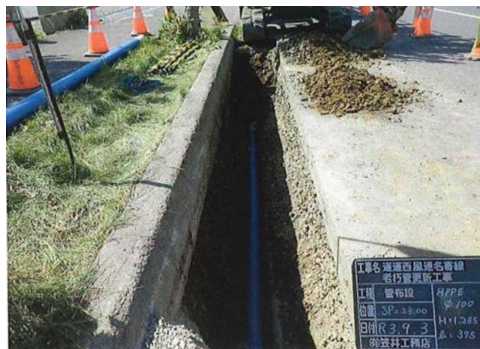
(老朽管更新事業)
