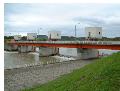
真勲別頭首工
