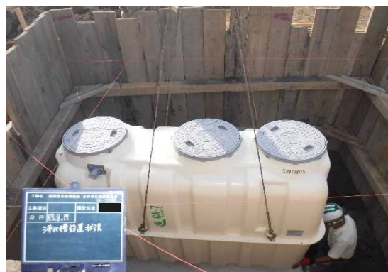
(施工写真②・浄化槽設置)
