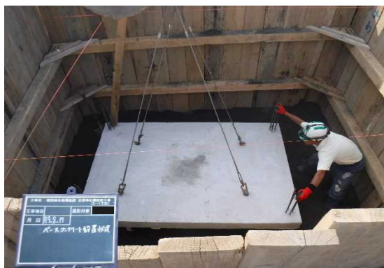
(施工写真①・底版据付)
