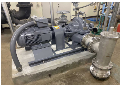
(緑丘浄水場機械設備更新工事)
