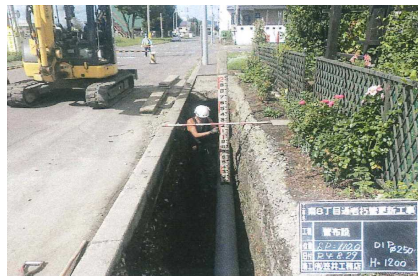
老朽管更新工事
