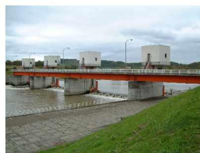
真勲別頭首工
