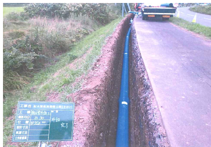
配水管新設整備工事（その2）
