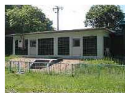
風連日進浄水場
