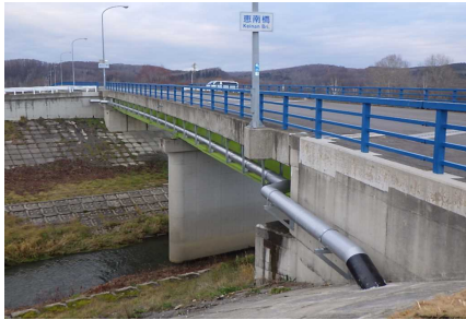
配水管新設整備工事（橋梁添架）
