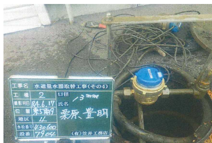
量水器取替工事
