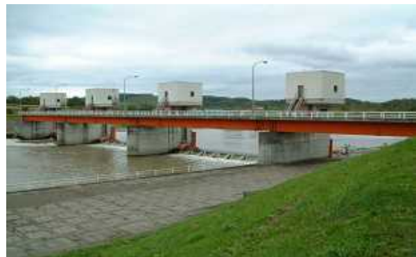
真勲別頭首工
